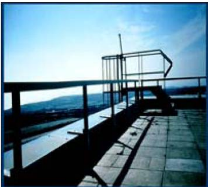
Garde-corps permanent avec accès fixe sur la terrasse où se trouvent les équipements de ventilation.
